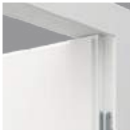
POLODRÁŽKA DVEŘNÍHO KŘÍDLA LÍCUJE SE ZÁRUBNÍ
