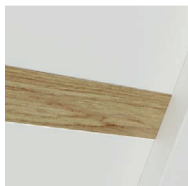
dekorační lišta z masivního dubu v modelu F.0, slícováno s povrchem panelu křídla, vodorovná struktura
